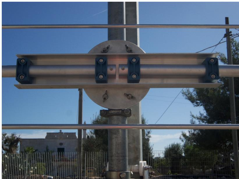
Se avete acquistato la versione con balun, collegare i ponticelli sul bulloni presenti sui semidipoli e fascettate il corpo del balun al mast in modo che non rimanga libero di oscillare nel vento.
